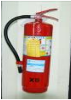
ถังดับเพลิงผงเคมีแห้งชนิดมือถือ ขนาด 15 ปอนด์
